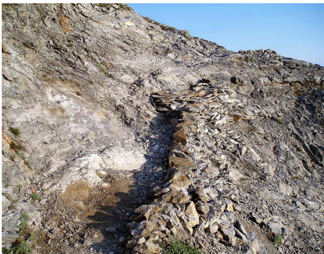
Επισκευή της Ξερολιθιάς στο πέρασμα του Γιώσου το 2008.
