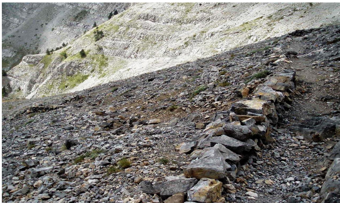
Φράξιμο με ξερολιθιά "κοψίματος" μονοπατιού.
