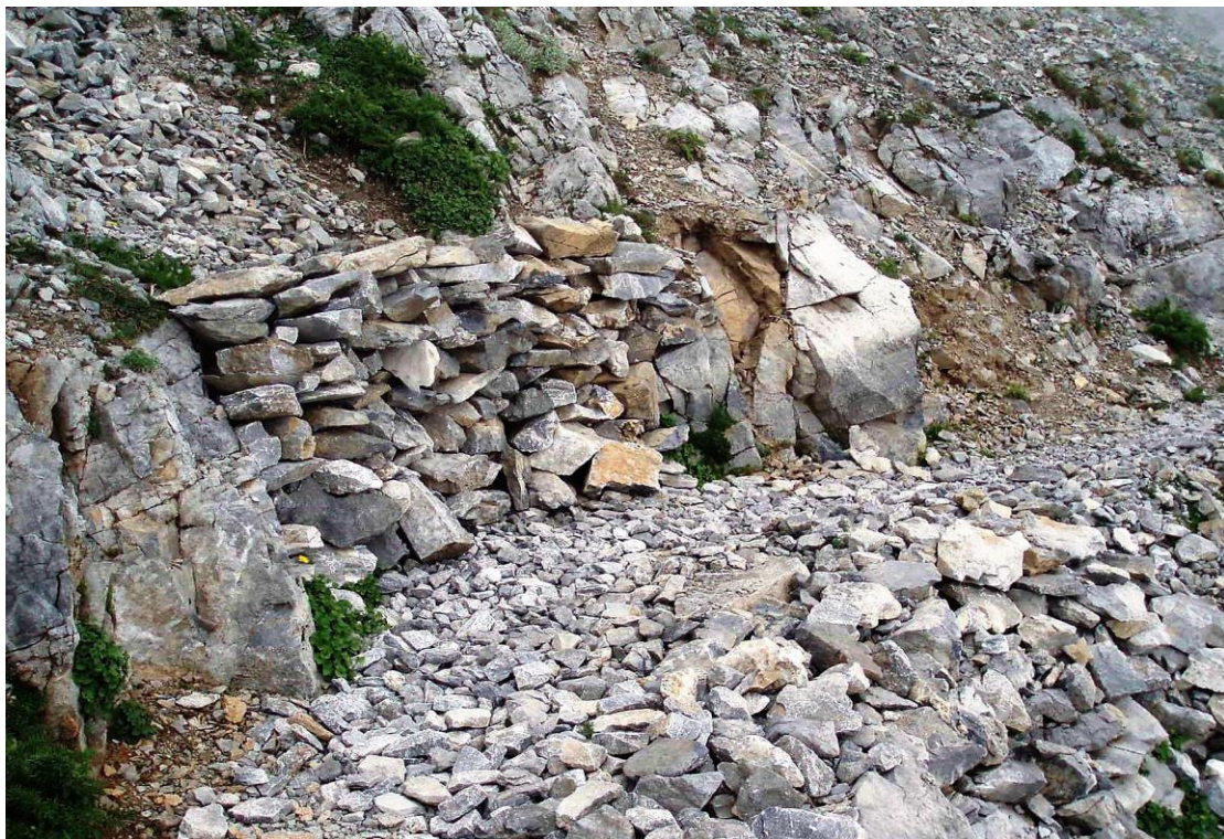
Ξερολιθιά προστασίας και στήριξης στο κεντρικό λούκι της Σκάλας.
